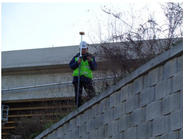
GPS측량기를 이용한 측량 작업
