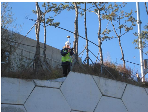
GPS측량기를 이용한 측량 작업
