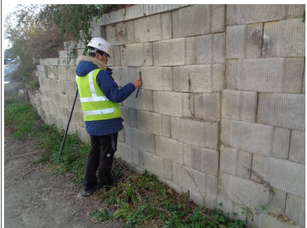
경사계를 이용한 경사도 측정
