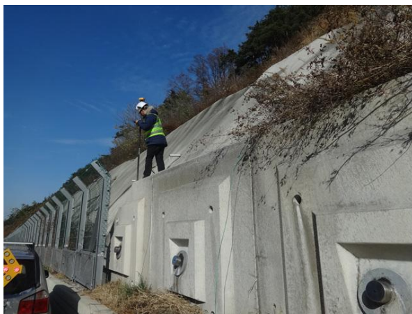
GPS측량기를 이용한 측량 작업
