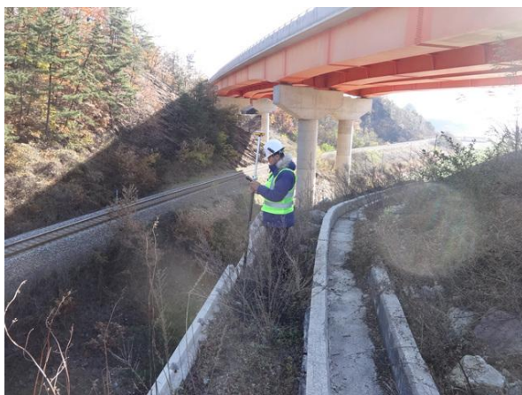
GPS측량기를 이용한 측량 작업
