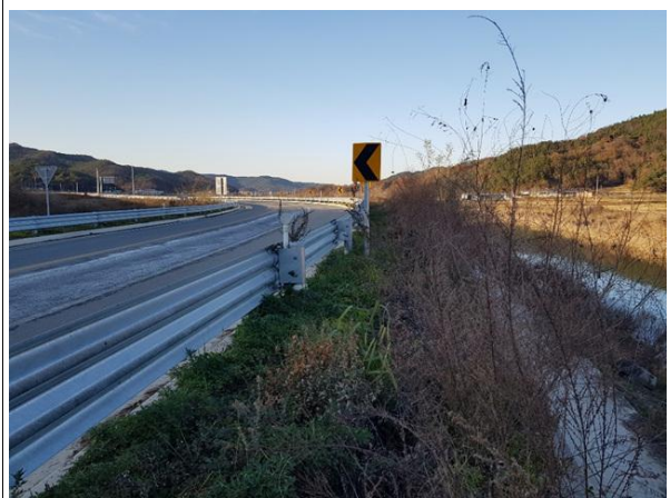
상부 성토부 전경
