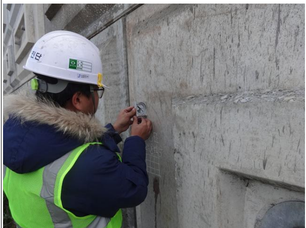
경사계를 이용한 경사도 측정
