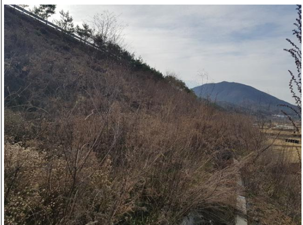
상부 성토부 전경
