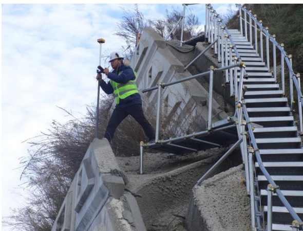
GPS측량기를 이용한 측량 작업
