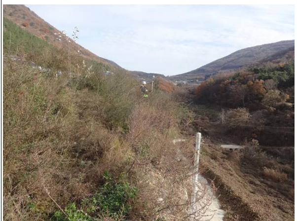
상부 성토부 전경
