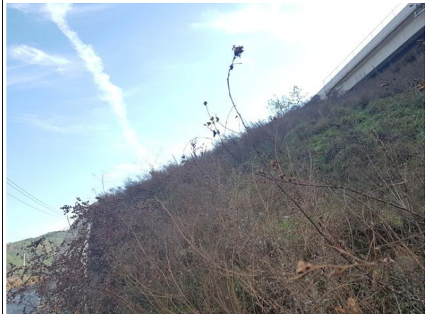
상부 성토부 전경
