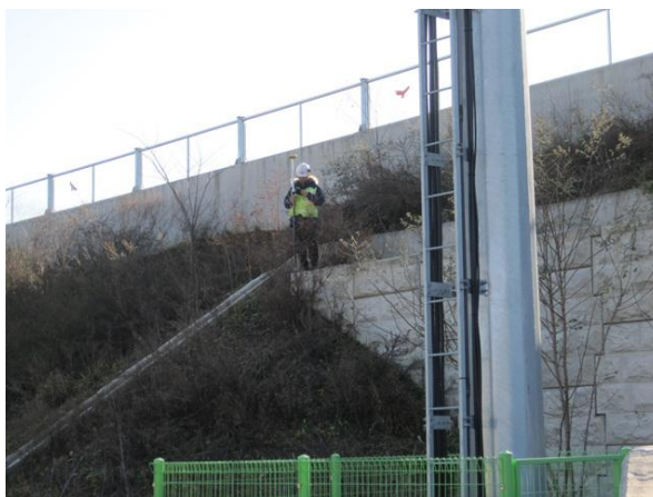
GPS측량기를 이용한 측량 작업
