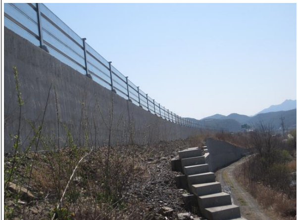
상부 성토부 전경
