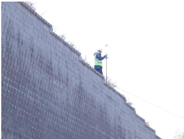
GPS측량기를 이용한 측량 작업
